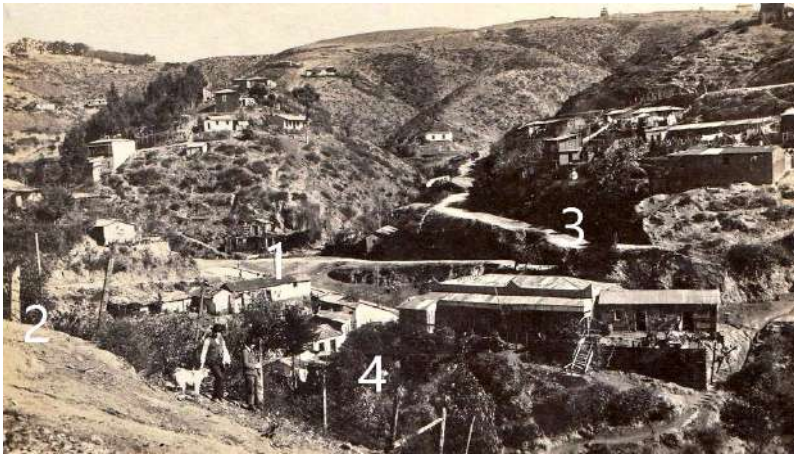
Imagen 4. Camino de Cintura con San Francisco, 1900 aproximadamente. Autor desconocido. Se aprecia 1. Camino de Cintura; 2. Cerro de la Cordillera; 3. Cerro Toro; y 4. Quebrada de San Francisco. Como vemos la zona habitada escasamente superaba Camino de Cintura, salvo por casas y ranchos aislados. Las zonas más urbanizadas se encontraban más cerca del plan o centro de la ciudad.
